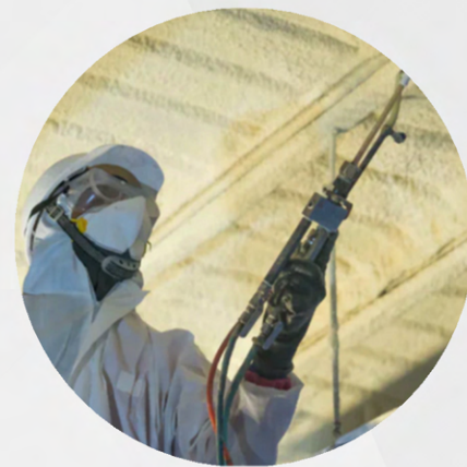
OCIEPLENIE PIANĄ PUR
