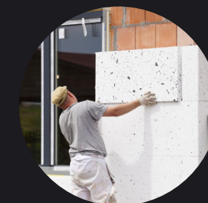
TERMOMODERNIZACJA CZYSZE POWIETRZE
